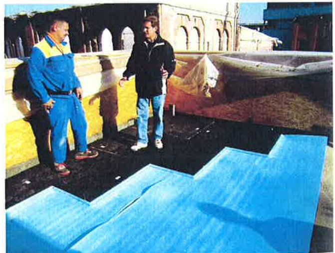
► Abbildung 5 VIP-Paneele-Verlegung
