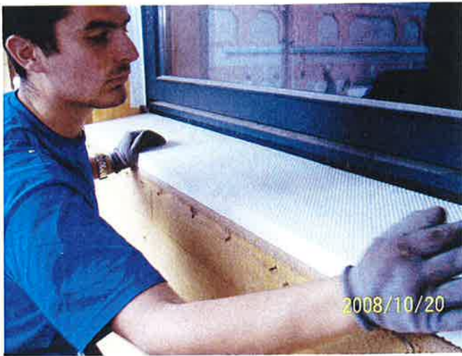
◀ Abbildung 6 EPS-Fensterbankdämmung
